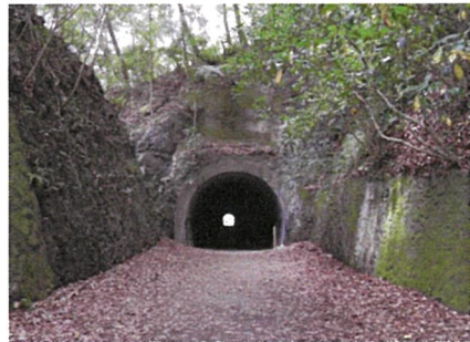
⑭ 長尾第2隧道
