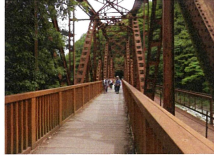
⑧ 第3武庫川橋梁
